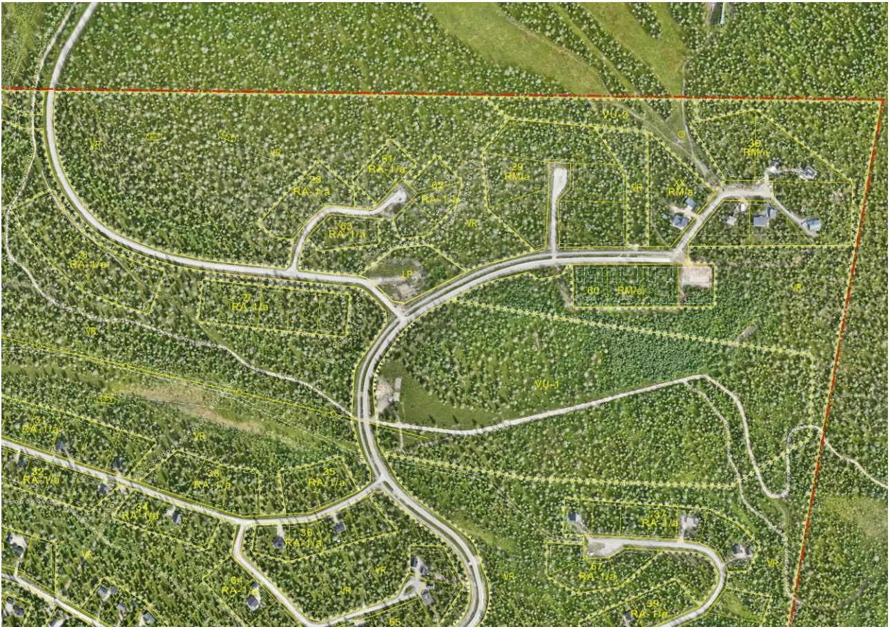
Kuva 18 Kirintövaaran huipun alue drone -kuvalla
